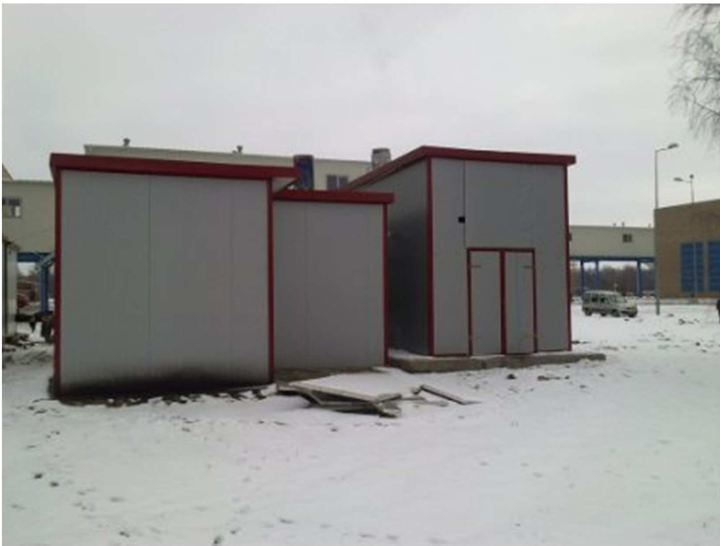
Rys. 8 Kotłownia kontenerowa 2000 kW i 1750 kW, Bogdanka
