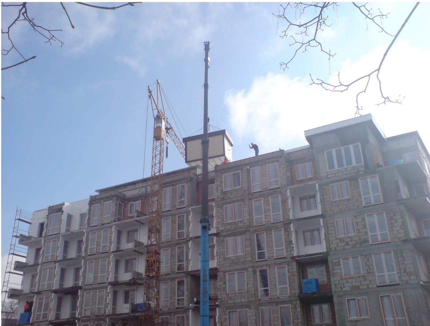
Rys. 10 Montaż kotłowni kontenerowej na dachu budynku
