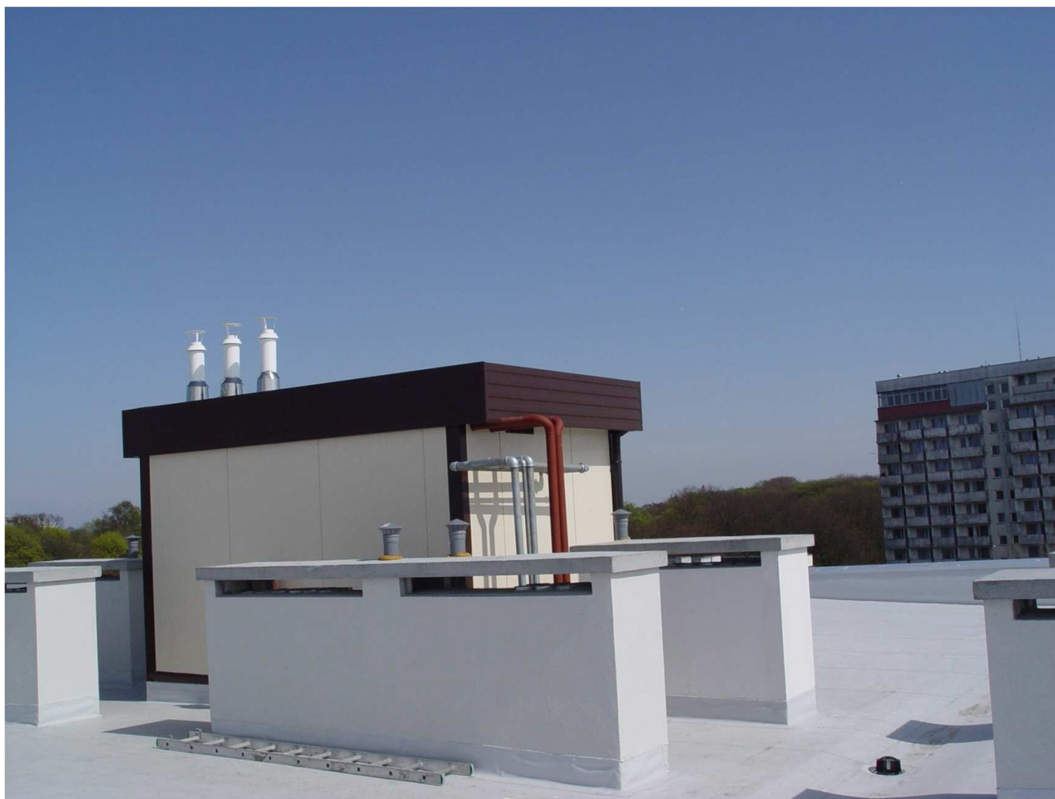
Rys. 1 Kotłownia o mocy 300kW, Kołobrzeg, ul. Portowa
