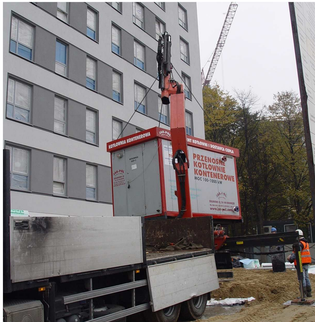
Rys. 11 Rozładunek kotłowni kontenerowej, Warszawa
